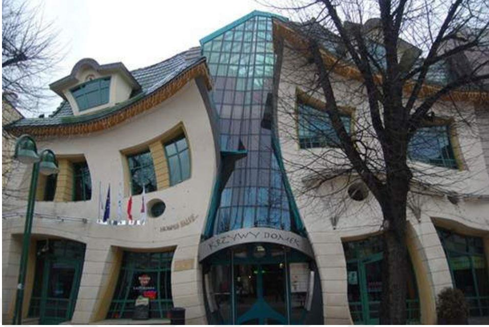
Şekil 39. Asimetrik bina örneği Krzywy Domek (Polonya-Sopot şehri)
