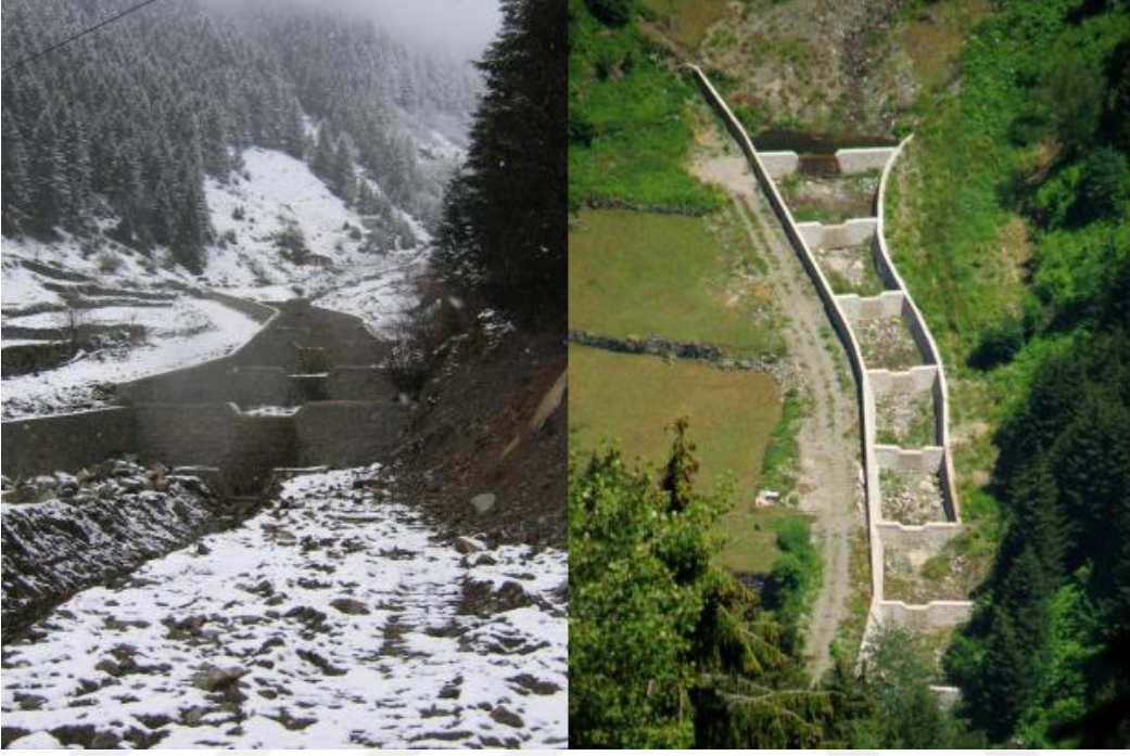
řekil 4. Uzungöl yan derede yapılan sistematik ıslah sekileri
