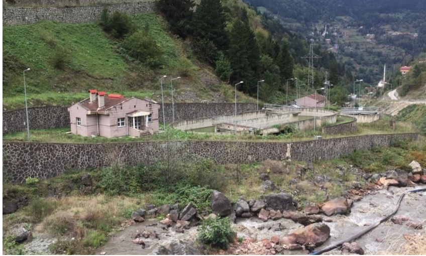
Şekil 15. Uzungöl biyolojik atıksu arıtma tesisi
