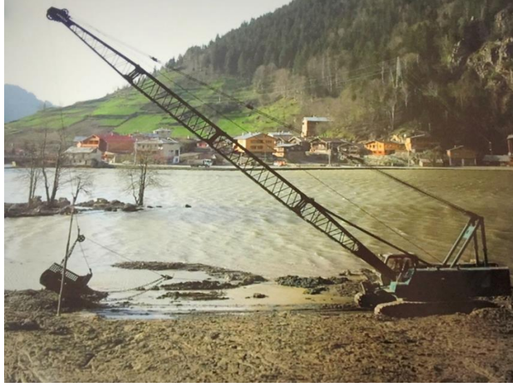
Şekil 16. Uzungöl’de 2004-2005 yılları arasında sallama kepçeyle yapılan dip tarama çalışma
