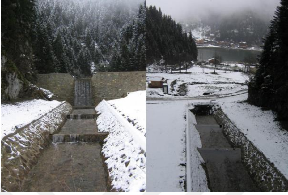
Şekil 5. Uzungöl yan derede yapılan tersip bendi ve pereli kanal
