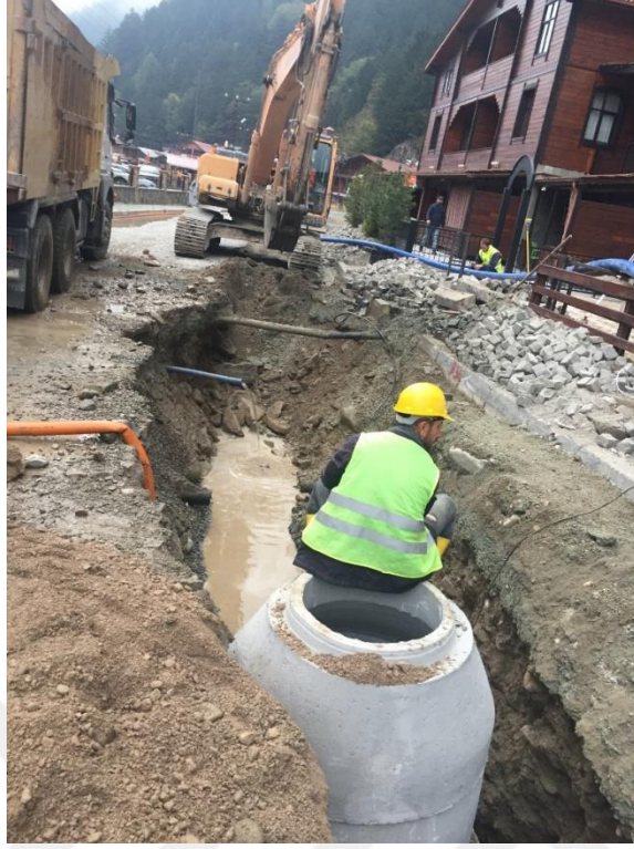
Şekil 14. Uzungöl yağmur suyu kanal çalışması
