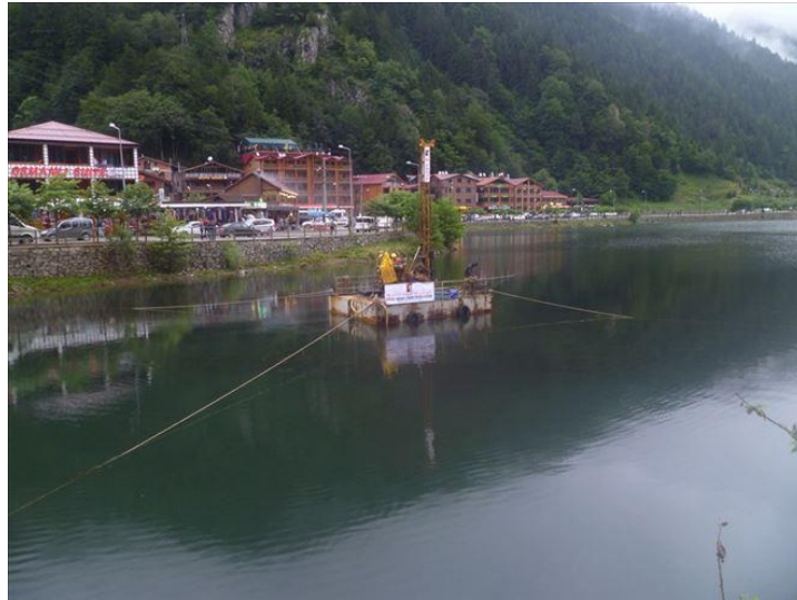
Şekil 18. Göl yüzey suyunda jeoteknik sondaj platformu
