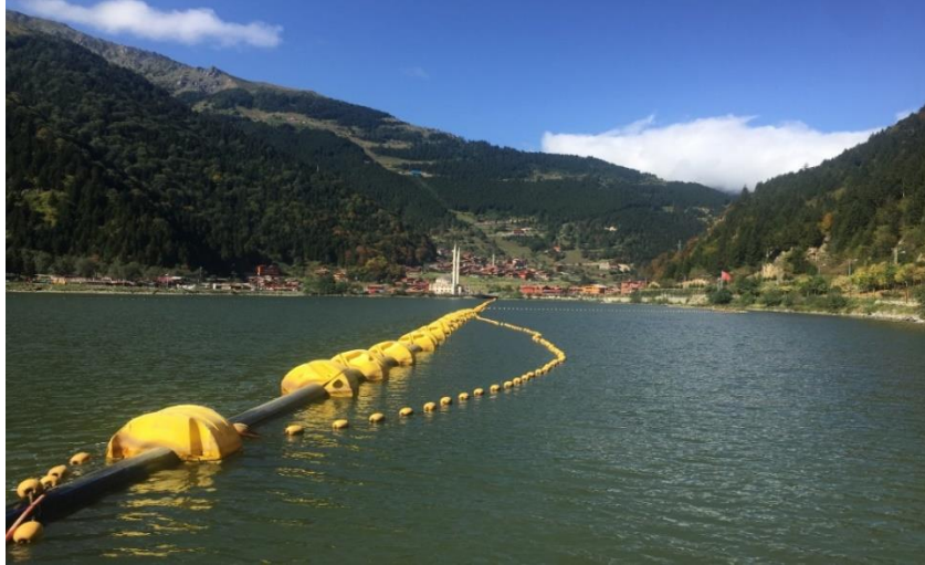
Şekil 27. Çamur İletim hattı, dubalı PE boru ve trafodan gelen enerji nakil hattı
