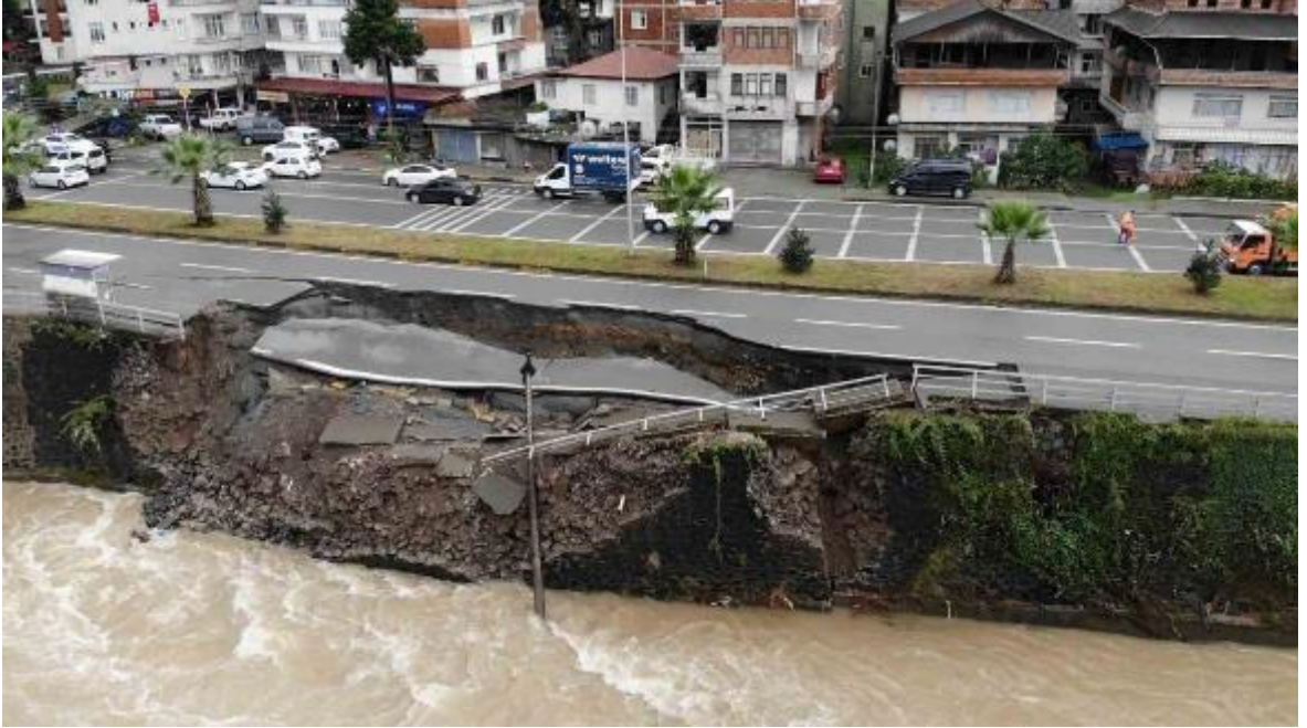
Şekil 27. 16 Eylül 2024 Tarihinde Meydana Gelen Yağışlar Sonrası Hopa-Artvin Karayolunda Meydana Gelen Çökme (URL 9)
