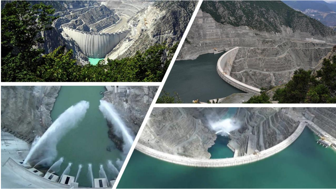
Şekil 8. Deriner Barajı'na ait bazı görseller
