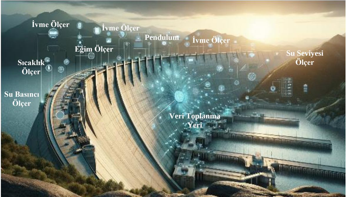
Şekil 6. Barajlarda kullanılan sensörlere ait bazı örnekler
