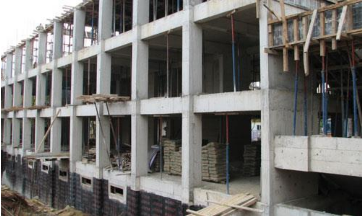
Betonarme Çerçeve Sistemli Bir Bina
