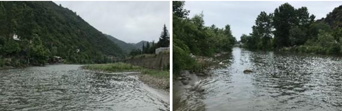
Şekil 16. D3 AKM gözlem istasyonu memba ve mansap görünümü (17.01.2022)
