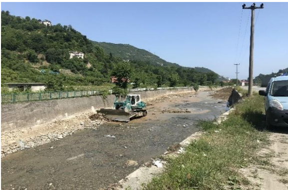
Şekil 30. Yomra Akarsuyu'nda akarsu kesitinde gerçekleştirilen taban düzeltme çalışmaları a) 11.06.2020, b) 26.06.2020
