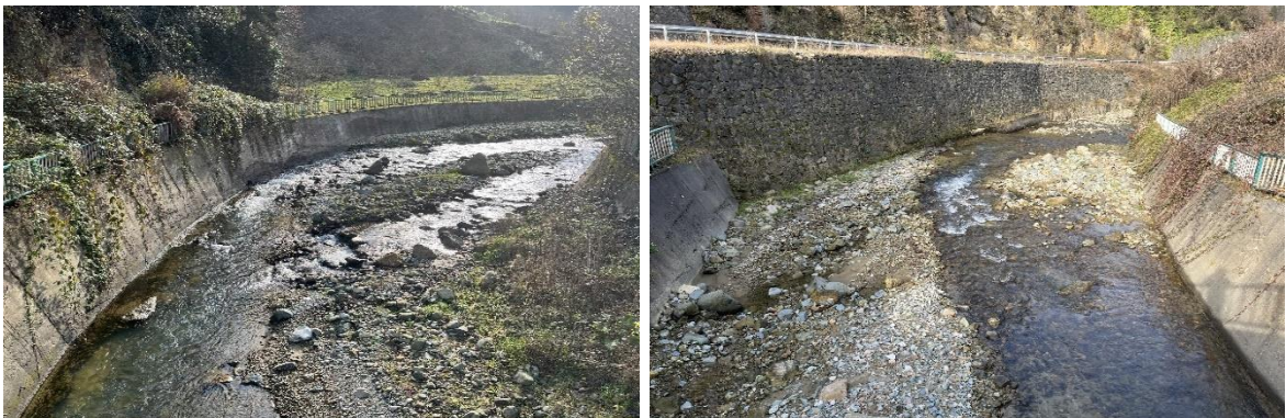
Şekil 22. Y2 AKM gözlem istasyonu memba ve mansap görünümü (19.09.2021)
