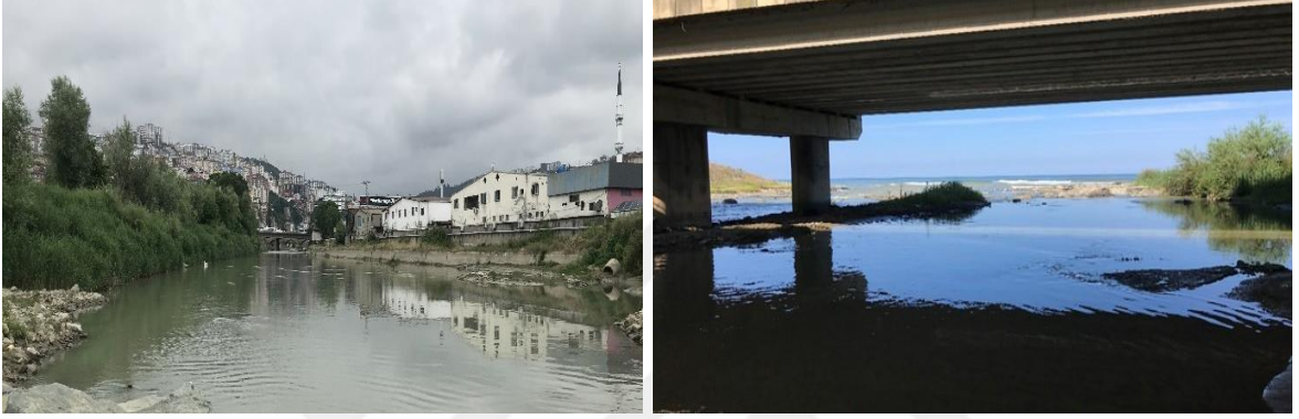
Şekil 17. D4 AKM gözlem istasyonu memba ve mansap görünümü (17.01.2022)
