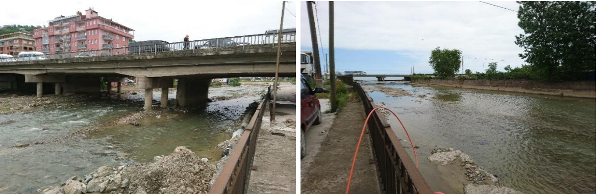
Şekil 24. Y4 AKM gözlem istasyonu memba ve mansap görünümü (27.05.2020)
