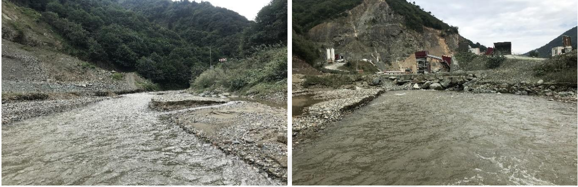
Şekil 21. Y1 AKM gözlem istasyonu memba ve mansap görünümü (17.01.2022)
