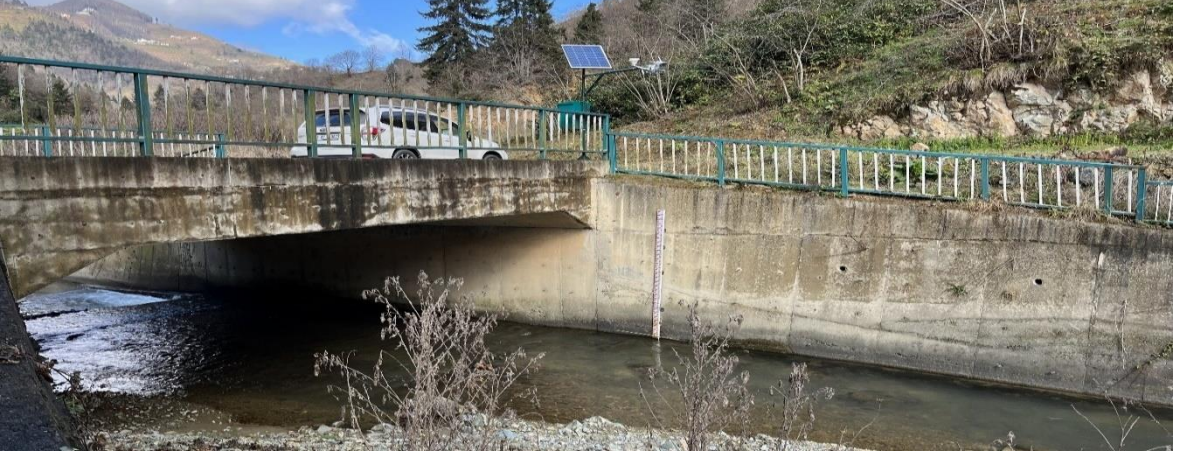
Şekil 41. Kömürcü Mahallesi radar sensörlü seviye gözlem istasyonu
