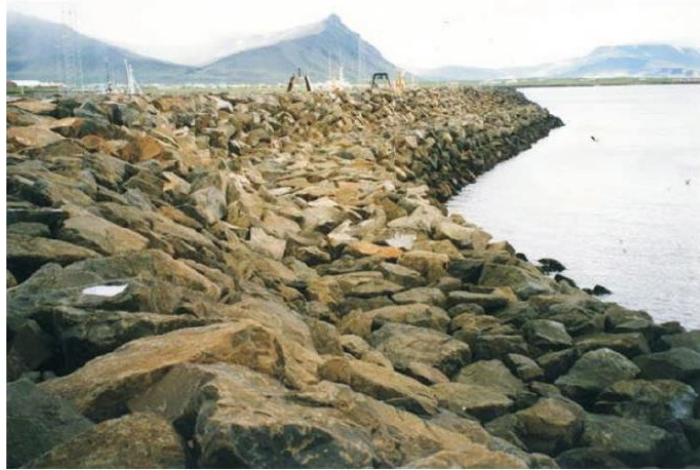
Şekil 5. Kıyı koruma yapısı olarak kullanılan palyeli taş dolgu dalgakıran (EurOtop, 2016)
